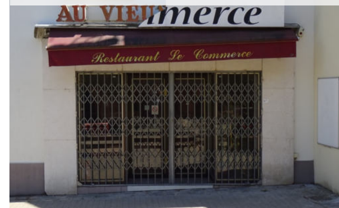
Commerce vacant en cours de réhabilitation - place Flatters (atopia)
