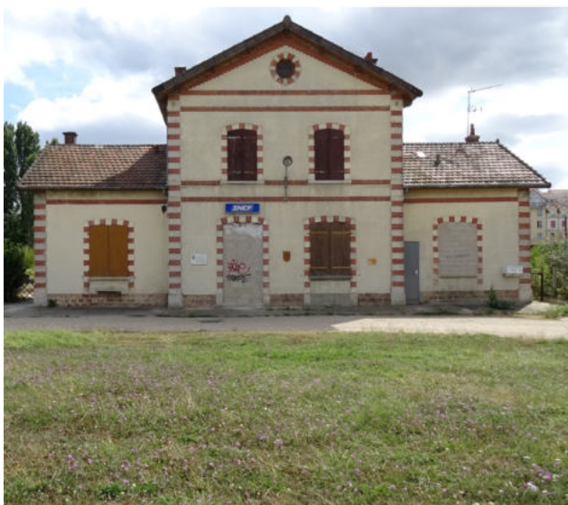
Gare désaffectée de Wissous (atopia)
